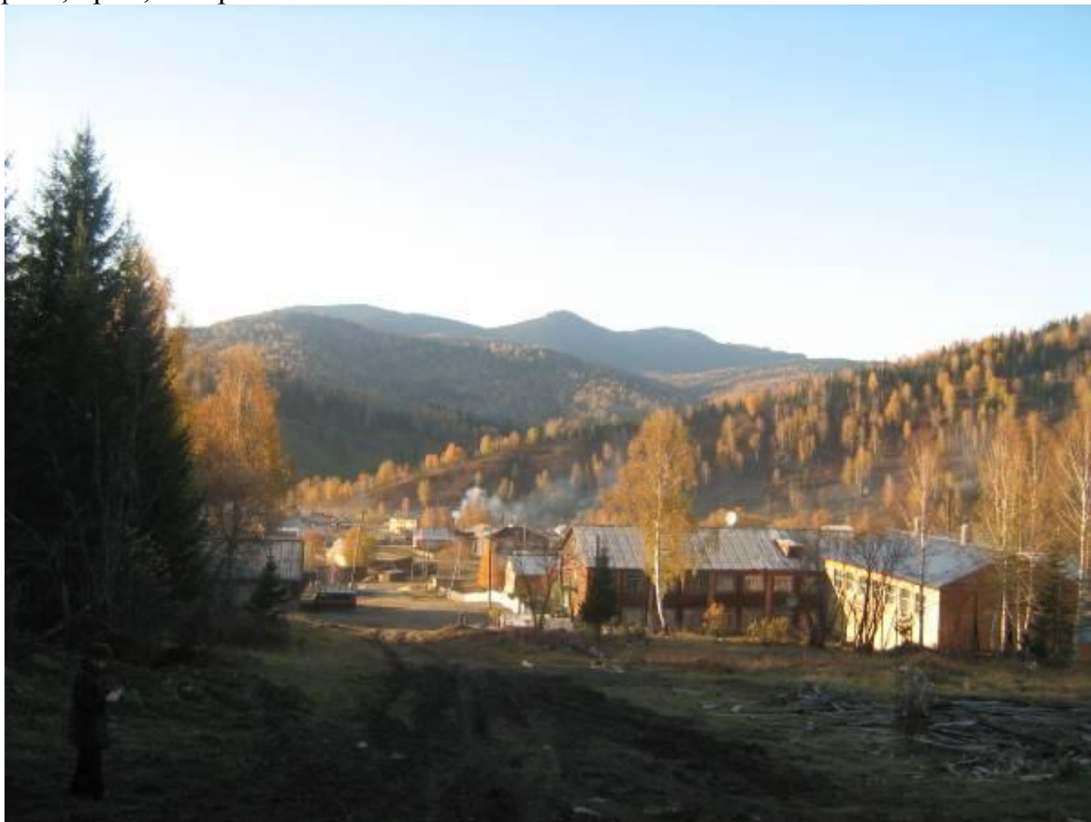
Строящийся образовательный комплекс МОУ СОШИ № 16
